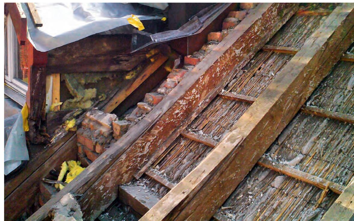
Vue sur la structure de toit dégagée avec plafond en plâtre et canisse de roseau côté combles. Le revêtement intérieur existant peut fréquemment faire office de couche d'étanchéité à l'air lorsqu'il est combiné avec de la ouate de cellulose isofloc.
