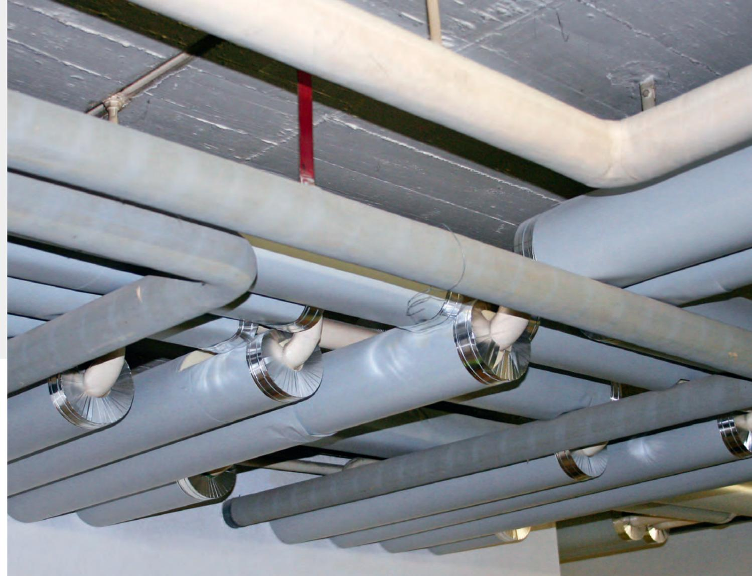
Les hauteurs et espaces divers entre les installations et le plafond de la cave peuvent être totalement remplis par insufflation de ouate de cellulose isofloc.
