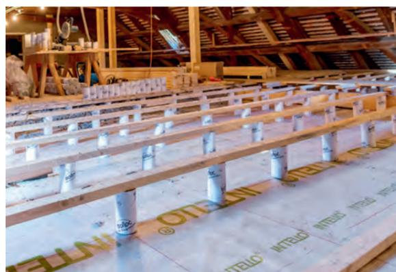
Mise en place d'isofloc Surplancher avant que ne soit posé dessus le revêtement de sol praticable.
