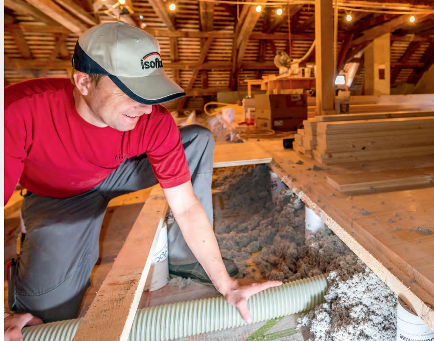
Les tubes isofloc Surplancher sont mis en place et recouverts avec un revêtement de sol praticable. La ouate isofloc peut alors être insufflée avec précision et sans aucun joint.
