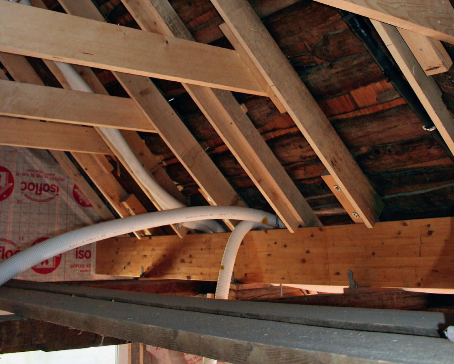
Dimensions et sauts de chevrons divers - le bois tordu reçoit un adossement latéral pour augmenter la section d'isolation et le nivellement. isofloc garantit une couche isolante compacte et sans joint.
