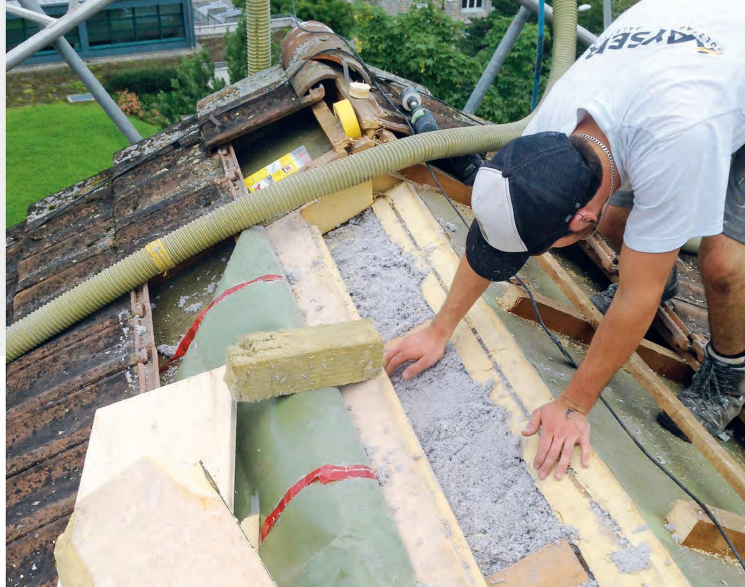
Le toit incliné est rempli par insufflation de ouate de cellulose isofloc depuis la faîte.
