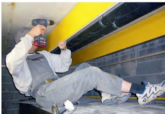
Plafond de cave en béton avec montage de cloisonnements d'écartement pour constituer la cavité à isoler par insufflation de ouate de cellulose isofloc.
