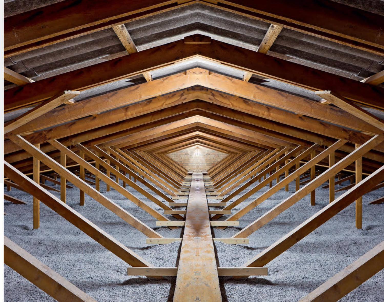
Soufflage à l'air libre avec passerelle au centre (une couche d'isolation soufflée à l'air libre ne résiste pas à la compression).
