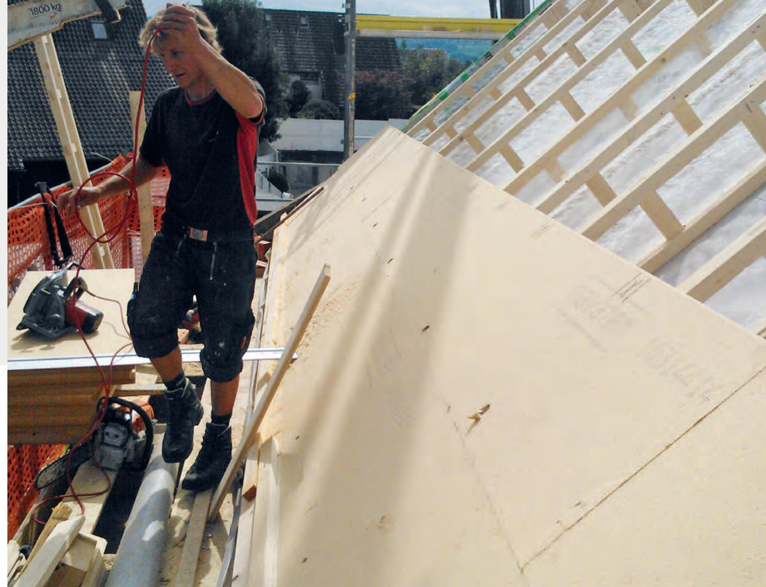
La sous-toiture est réalisée avec des panneaux de fibres de bois Pavatex. La cavité à isoler entre les poutres U\*psi est isolée avec de la ouate de cellulose isofloc.
